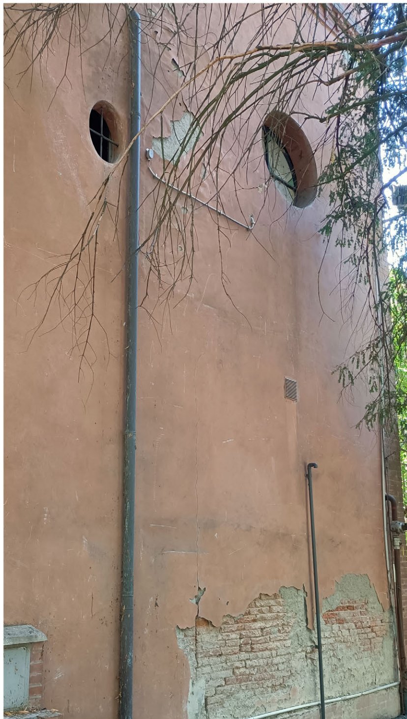
fotoinserimento: griglia esterna di protezione del foro di areazione, praticato ai fini del rispetto delle norme di sicurezza antincendio
